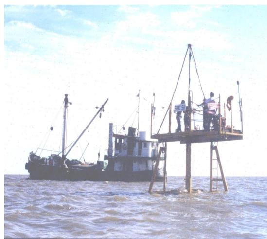
**Foto N° 1:** Plataforma de trabajo para ejecutar perforaciones geotécnicas en el Río de La Plata.
