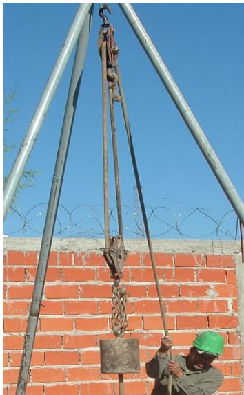
Figura N° 13: Con aparejo simple.
