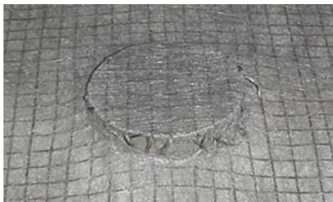
Foto N° 4: Punzonado de la geogrilla sobre la cabeza del pilote
