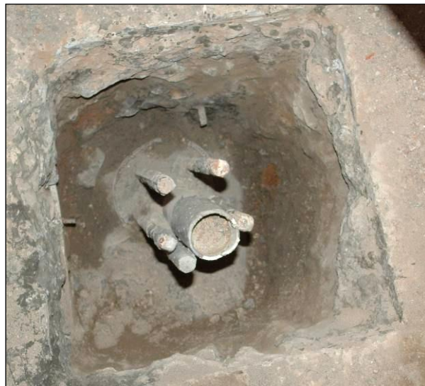
Figura N° 37: Micropilote terminado
