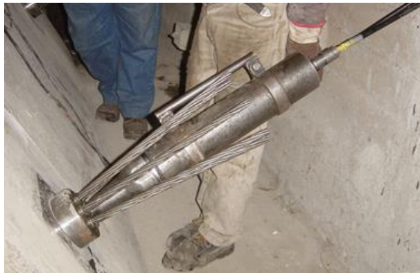
Figura N° 82: Gato hidráulico para el tesado de los mismos
