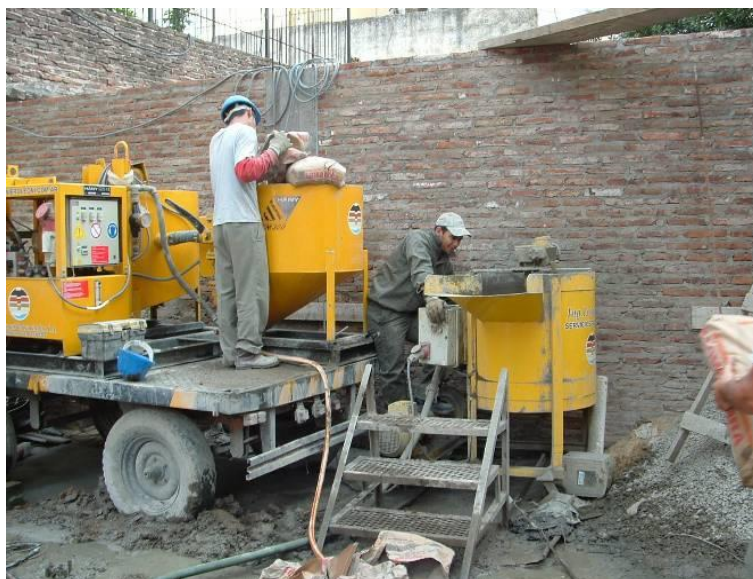
Figura N° 35: Equipos de inyecciones trabajando en obra
