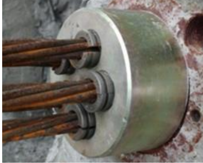
Figura N° 81: Cabezal de anclaje de cuatro cordones
