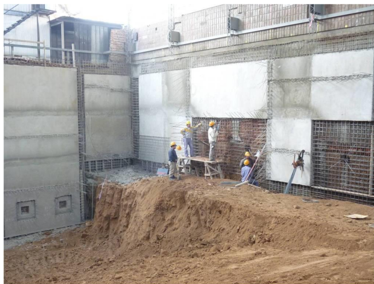
Figura N° 69: Construcción de tabiques y anclajes
