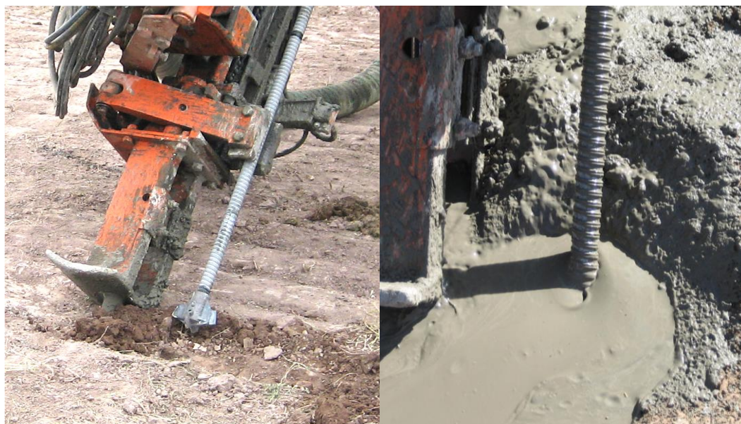
Figura N° 11 a: Perforación con inyección de lechada de cemento para un anclaje con barras ISCHEBECK
