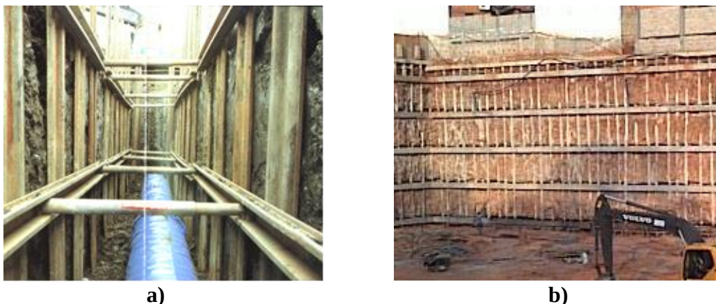
Figura N° 53: Entibamiento parcial en suelos cohesivos
