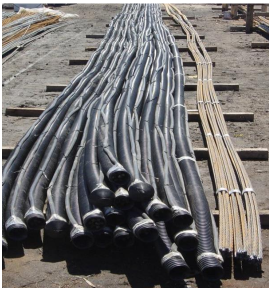
Figura N° 78: Vaina corrugada y cordones trenzados para anclajes activos permanentes
